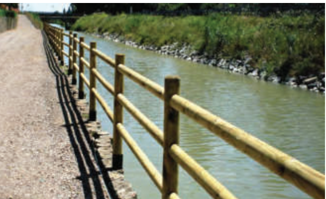
COD STLA STACCIONATA LAVARONE - LAVARONE FENCE
